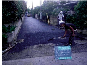
道路緊急修繕
